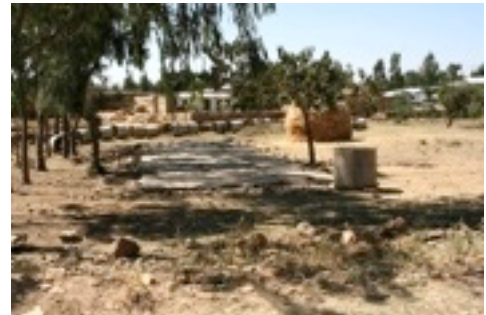
Das Baugelände für das Museum in Wuqro
